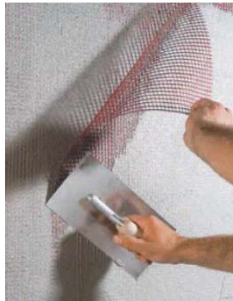
Bild 8: Armierungsputz mit Gewebeeinlage
