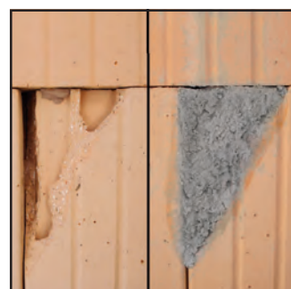
Kimmschicht erstellen, Fehlstellen und Stoßfugen vermörteln – alles mit dem selben Mörtel möglich!
