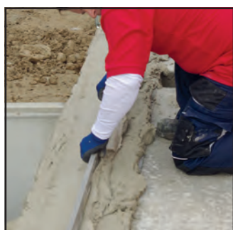
Der überschüssige Mörtel wird mit einer Alulatte abgezogen.
