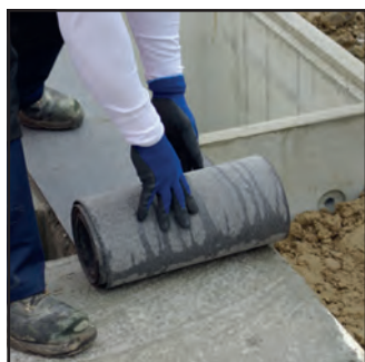
Auf der Betondecke wird zunächst eine Bitumpappe R500 ausgelegt (Stöße 20 cm überlappend).
