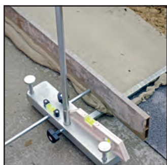
Es entsteht eine ebene Unterlage für die erste Ziegellage – Grundlage für das exakte Hochziehen der Wand.
