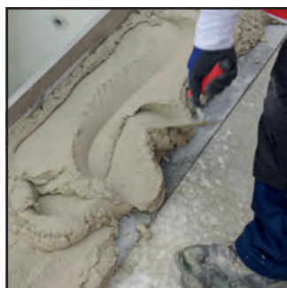
Dazu wird zuerst mit der Schaufel großzügig Kimmschichtmörtel aufgebracht und mit der Kelle verteilt.
