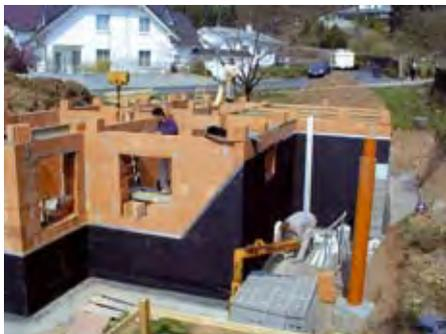
Abdichtung mit selbstklebenden EPDM-Dichtungsbahnen
