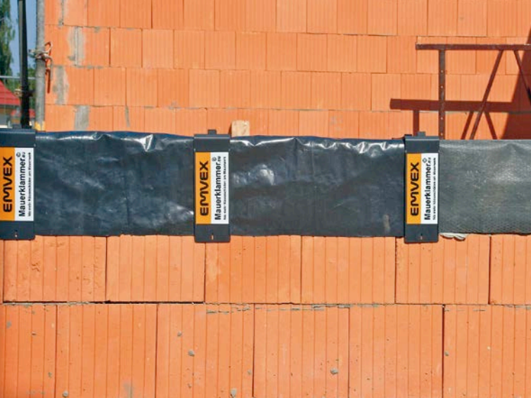
Mauerwerk im Bauzustand: Fachgerecht abgedeckte Mauerkronen
