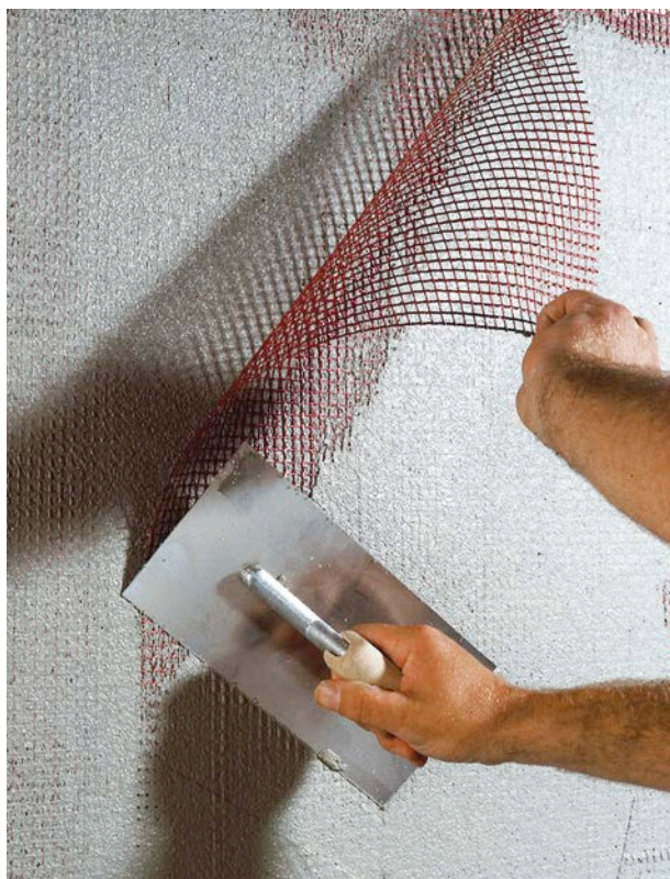
Vollflächiges Einbetten des Armierungsgewebes in einen Armierungsmörtel
