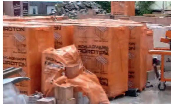
**Bild 3.1-2:** Mauersteine – bauseitiger Schutz vor Durchfeuchtung
