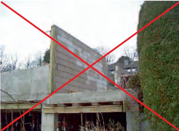
**Bild 11-6:** Durchfeuchtung von Mauerwerkswänden von oben
