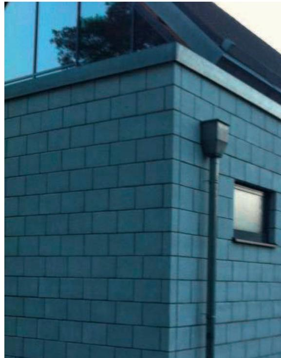
**Bild 10.5-2:** Empfehlenswerte Anordnung einer vertikalen Dehnungsfuge
