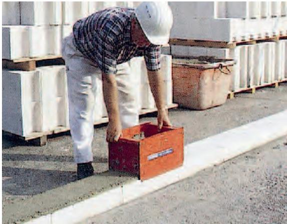
**Bild 5.3-1:** Sachgerechter Mörtelauftrag mit Mörtelschlitten
