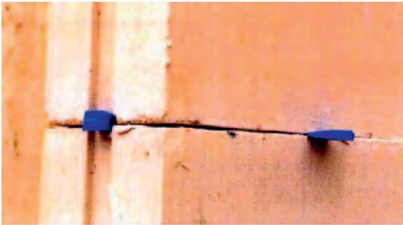
**Bild 6.4-1:** Unzulässiges Ausrichten von Planelementen mit Keilen
