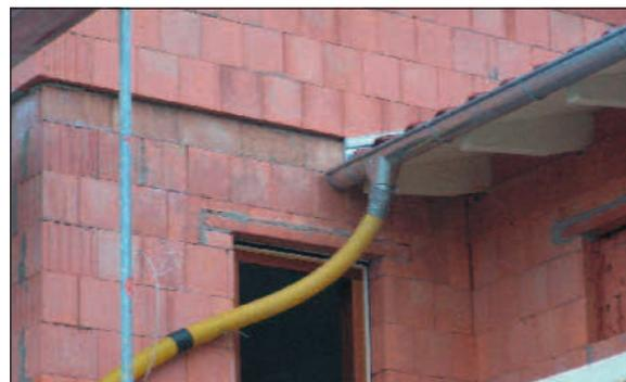
**Bild 11-4:** Unschädliches Abführen von Regenwasser
