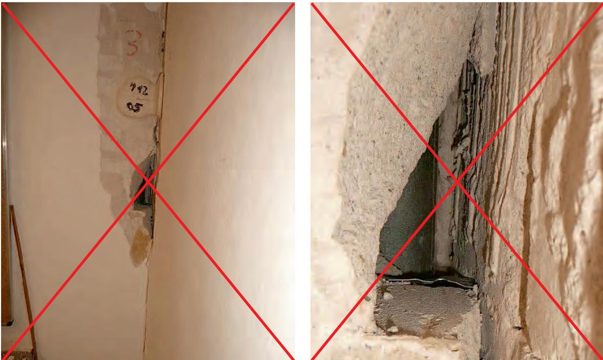
Bilder 7-6 und 7-7: Rissbildung am Wandanschluss, der Anker liegt unvermörtelt in der Lagerfuge
