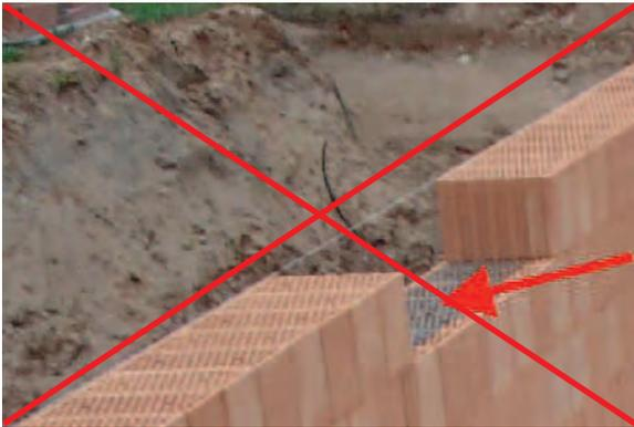
**Bild 6.3-6:** Regelwidriger Mörtelauftrag nur im mittleren Bereich der Wanddicke [31]
