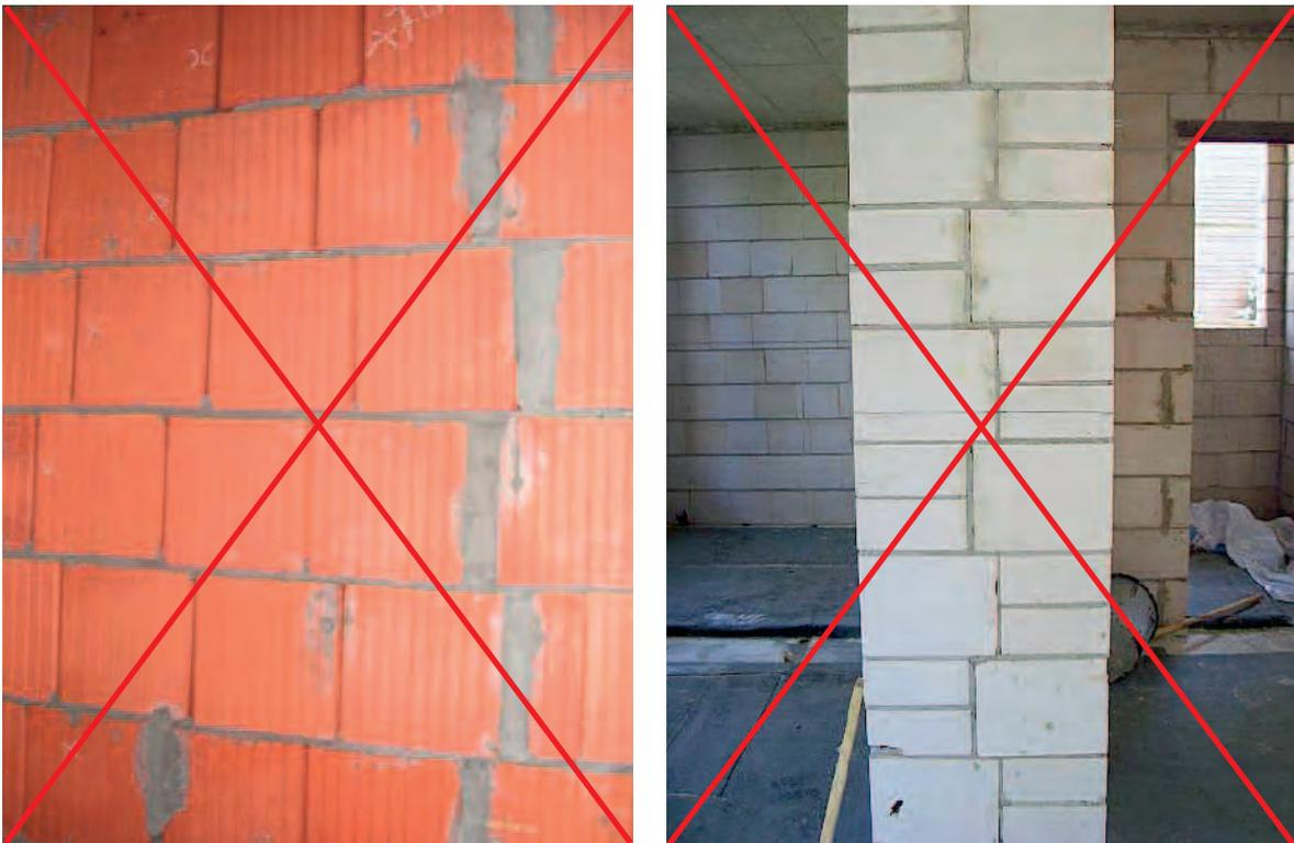
Bilder 4-4 und 4-5: Mauerwerk mit zu geringem Überbindemaß
