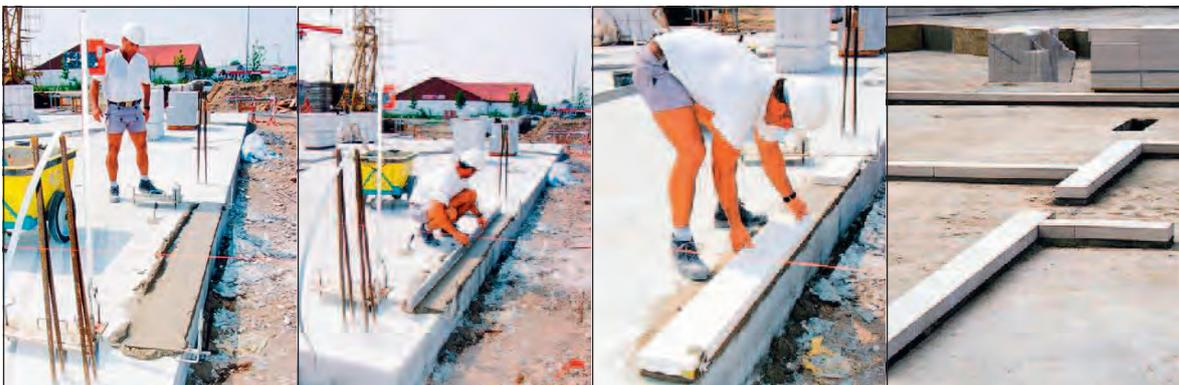
Bilder 6.2-1 bis 6.2-4: Ausführen der unteren Kimmsteinlage
