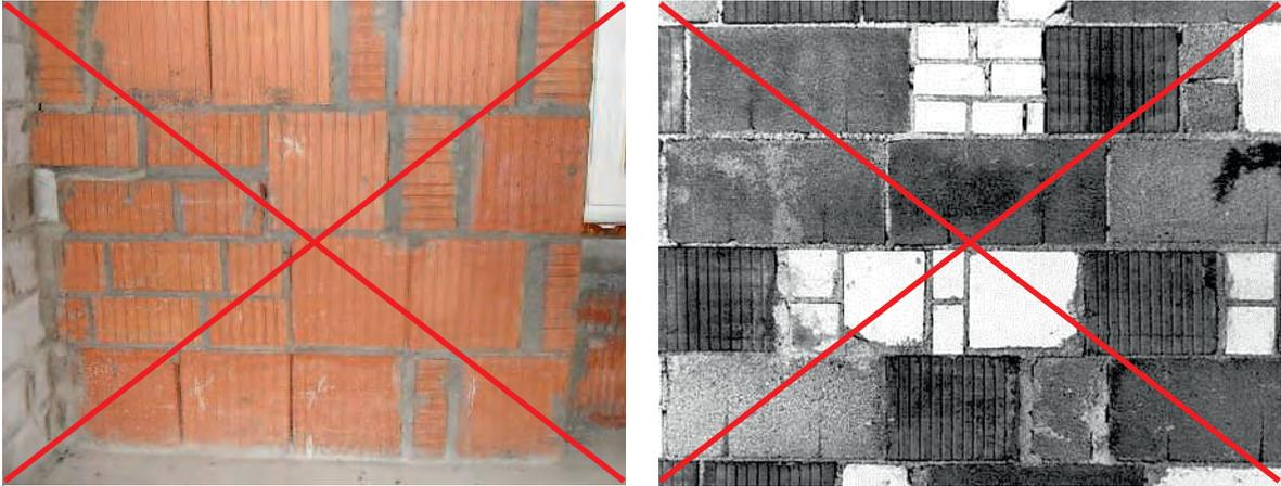
Bilder 5.1-3 bis 5.1-6: Regelwidrig ausgeführtes Mauerwerk
