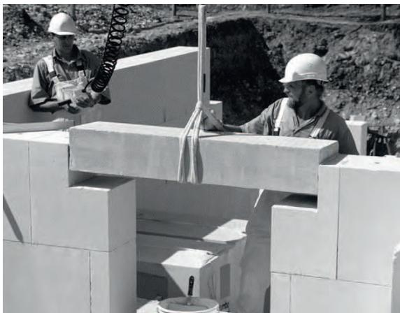
Bild 12.4-1: Fertigsturz (Beispiel Porenbeton)
