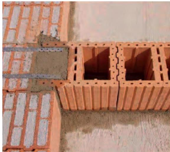
**Bild 7-4:** Schlitzverankerung
