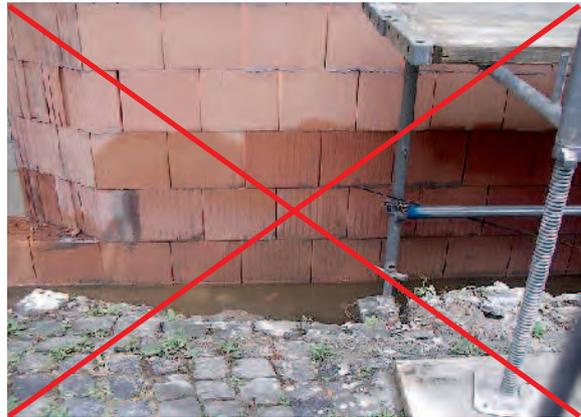
**Bild 11-7:** Durchfeuchtung von Mauerwerkswänden von unten
