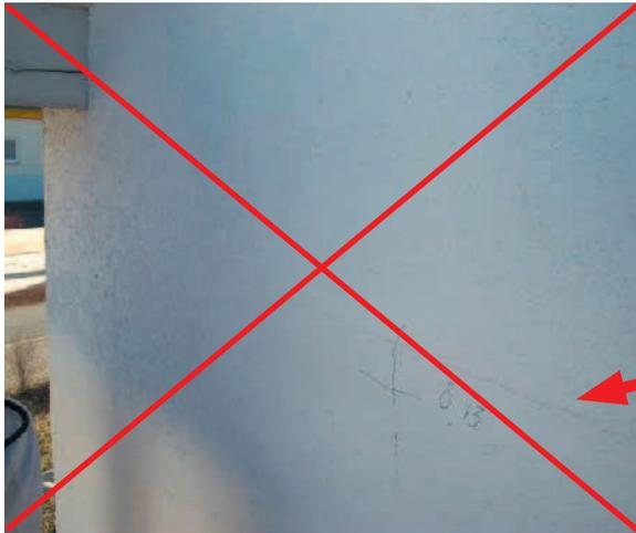
*Bild 12.1-2: Horizontalriss am Deckenaufleger durch fehlende Trennlage*
