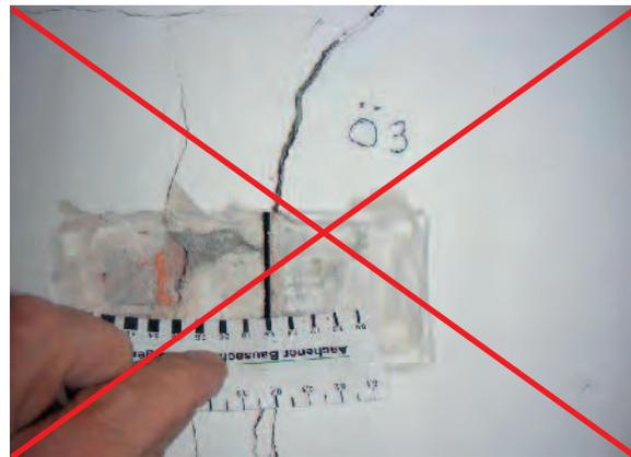
Bild 12.3-3: Rissbildung im Anschlussbereich der Wand unter dem Ringbalken
