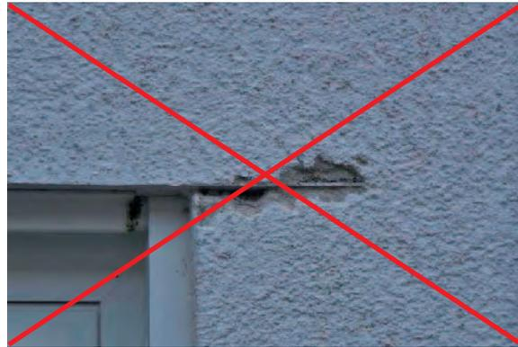
**Bild 12.5-3:** Randwinkel nicht eingekürzt, Bewehrung fehlt
