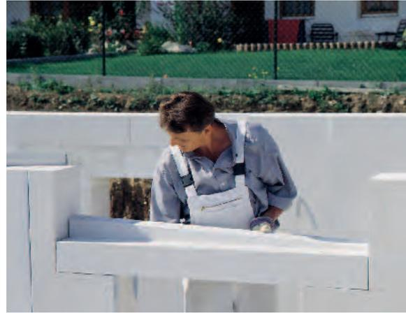
**Bild 12.4-2c:** Flachsturz (Beispiel Porenbeton)
