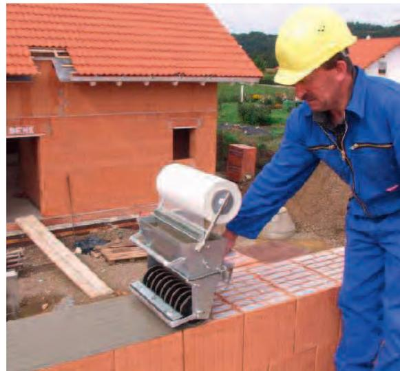
Bild 6.3-4: Mörtelauftrag aus Kasten mit Gewebe
