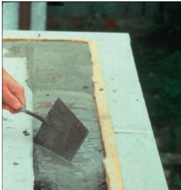
Bilder 12.2-1a und 12.2-1b: Ringankerbewehrung in Stein-U-Schalen
