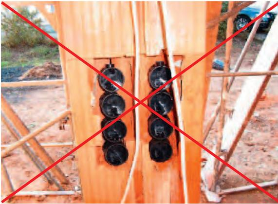
*Bild 8-2: Regelwidrige Ausführung von Schlitzten, Aussparungen in einem tragenden Pfeiler (ohne statischen Nachweis), aus [31]*
