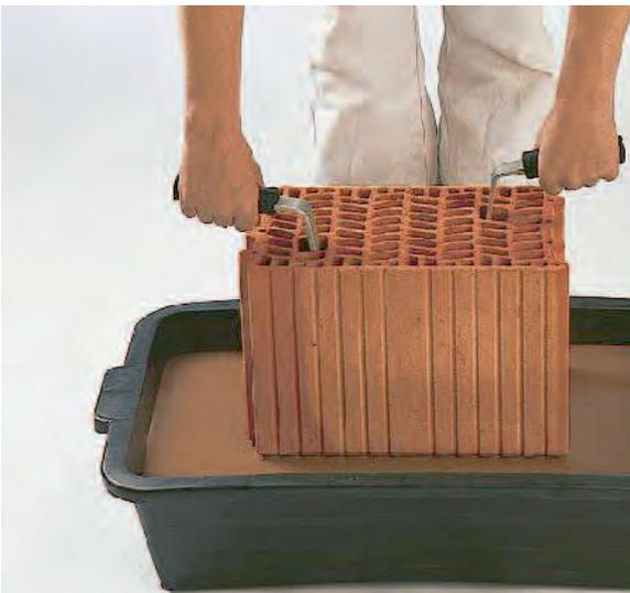
Bild 6.3-3: Mörtelauftrag durch Tauchen
