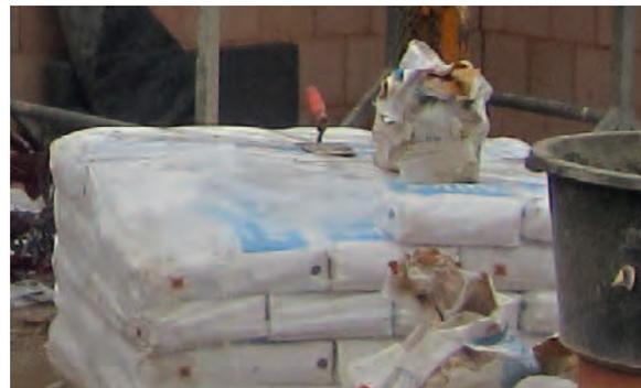
**Bild 3.2-2:** Mauermörtel (Sackware auf Palette) – Schutz vor Durchfeuchtung
