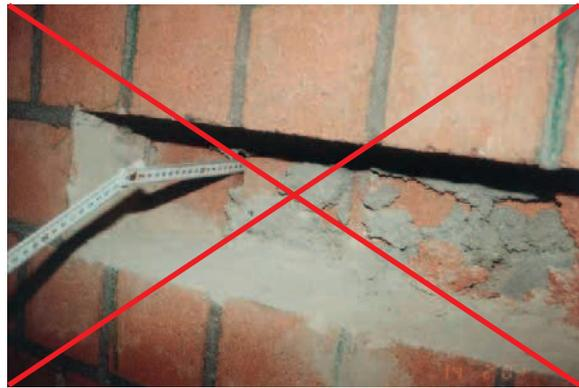
Bild 5.3-4: Verbandsmauerwerk; fehlende Vermörtelung der Längsfuge
