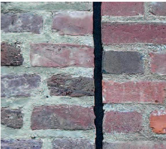
**Bild 10.5-4:** Mit vorkomprimiertem Dichtungsband geschlossene Dehnungsfuge
