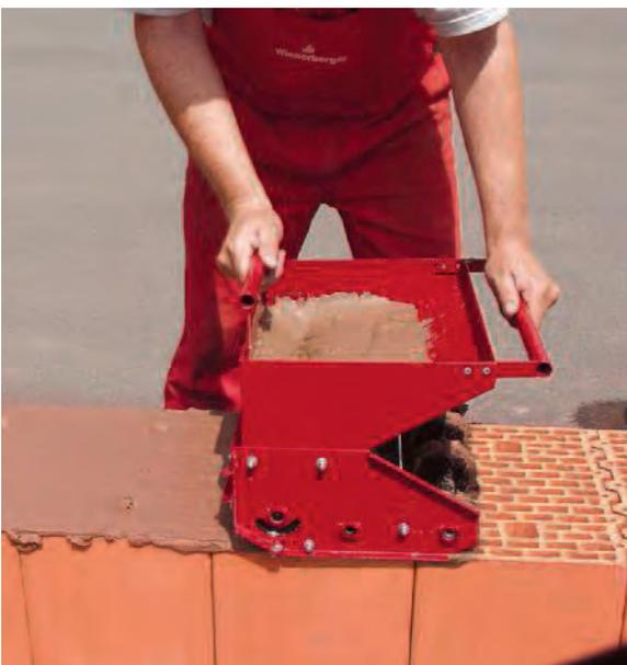
Bild 6.3-5: Mörtelauftrag als Deckmörtel aus Mörtelschlitten
