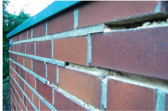
**Bild 10.4-5:** Schadhafter Fugenabschluss bei nachträglichem Verfugen
