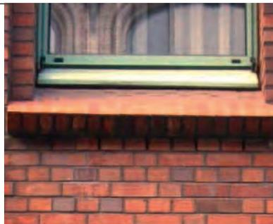
**Bild 12.6-2:** Stark geneigte Rollschicht (Fertigteil)
