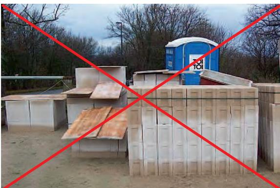
**Bild 3.3-1:** Mauersteine nicht vor Durchfeuchtung, Bodenkontakt, geschützt
