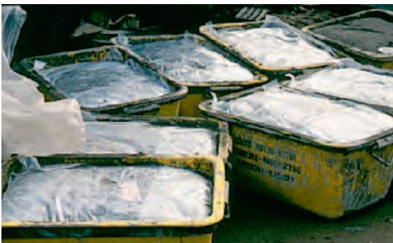
**Bild 3.2-3:** Werk-Frischmörtel (Mörtelkübel abgedeckt) – Schutz vor Austrocknung und Beregnung
