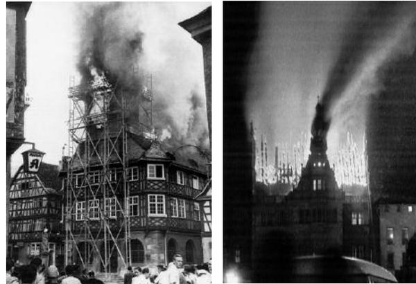
Aus dem Foto ist deutlich erkennbar, wie sich Mauerwerk im Brandfall verhält. Deshalb wurden in Städten im Mittelalter auch aufgrund großer Stadtbrände Brandwände und Schornsteine aus Mauerwerk vorgeschrieben. Damit wurde die Brandausbreitung begrenzt und die Feuerwehr hatte die Chance zu löschen.
