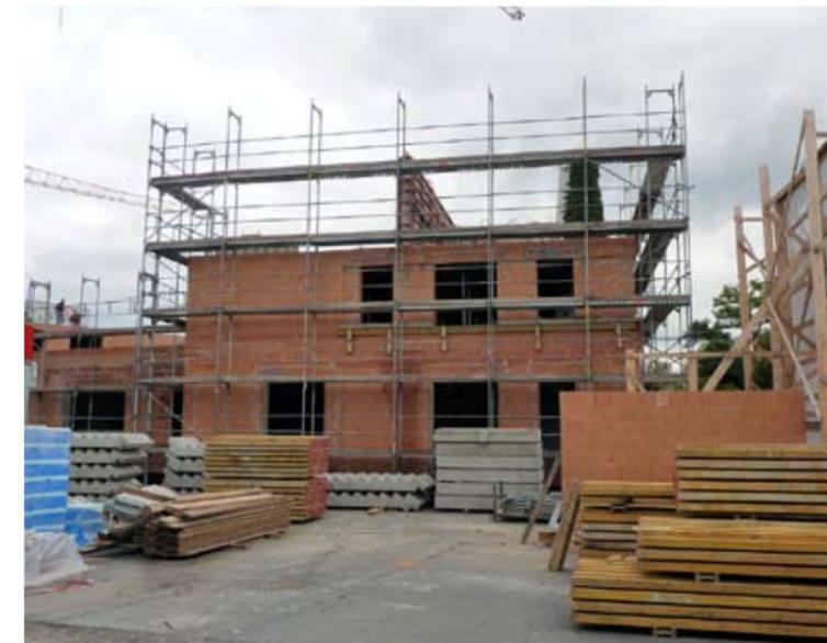
Mit einem Schalldämm-Maß von 49dB bei einer Wandstärke von 36,5cm bei gleichzeitigem Wärmeleitwert von  $\lambda = 0,13 \text{ W/(mK)}$  ist der TS13 optimal auf die Anforderungen im Geschosswohnungsbau abgestimmt.
