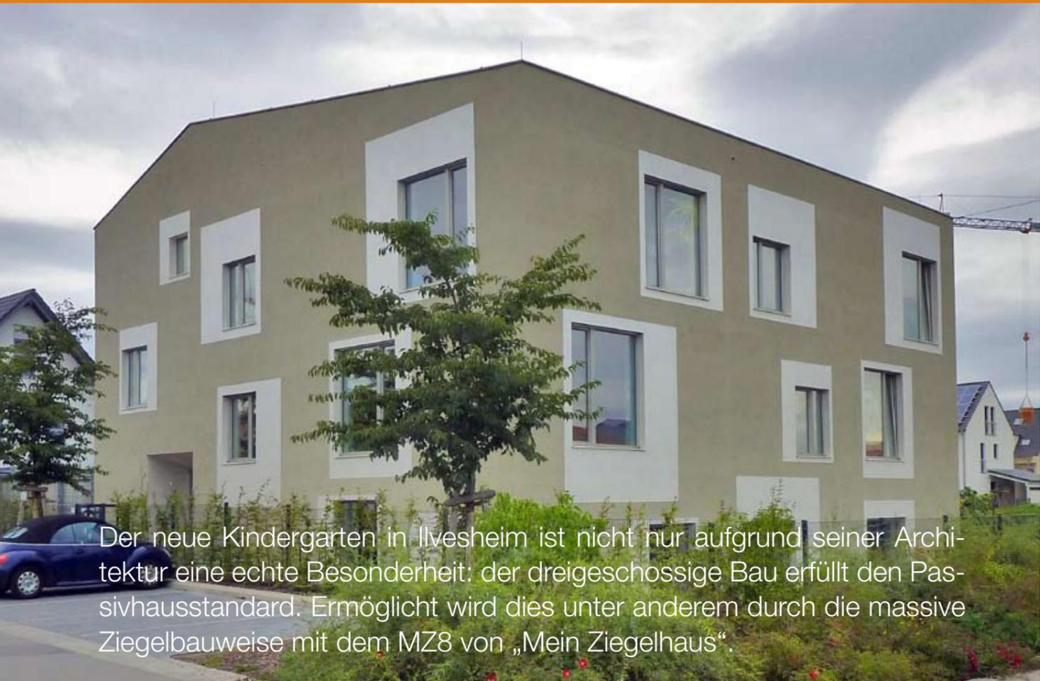
Der neue Kindergarten in Ilvesheim ist nicht nur aufgrund seiner Architektur eine echte Besonderheit: der dreigeschossige Bau erfüllt den Passivhausstandard. Ermöglicht wird dies unter anderem durch die massive Ziegelbauweise mit dem MZ8 von „Mein Ziegelhaus“.
