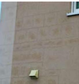
Verputztes Ziegelmauerwerk ist eine beliebte und bewährte Außenwandkonstruktion. In einem Zeitraum vor 10, 15 oder 20 Jahren traten allerdings häufiger Schäden am Putz auf. Die Ziegel hatten sich durch die ständig gestiegenen Anforderungen an die Energieeffizienz kontinuierlich weiterentwickelt und es wurde auch ein neues Bausystem mit Dünnbettmörtelfuge, das
