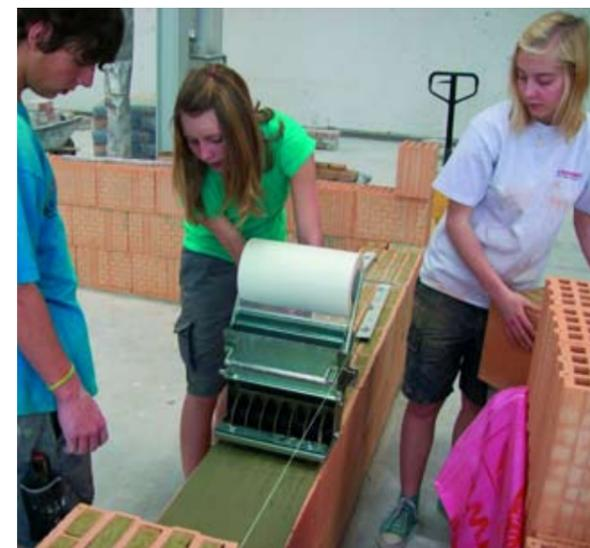
de des Musterhauses kamen normale Planziegel und der Wärmeschutzziegel MZ8 zum Einsatz. Der MZ8 besticht durch eine Wärmeleitfähigkeit von  $0,08 \text{ W/(mK)}$  und erfüllt damit alle wandbezogenen Anforderungen an energieeffiziente Gebäude.
