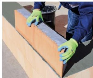
Die Elemente werden in den frischen Mörtel gesetzt und ausgerichtet. Durch die große Elementlänge erreichen Sie eine hohe Verlegeleistung und es sind keine zusätzlichen Schalungsarbeiten notwendig.
