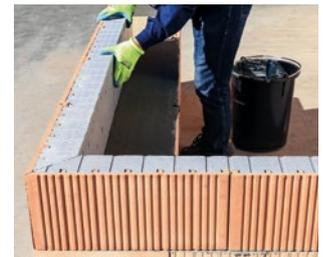
Auch an den Ecken ergibt sich durch die auf Gehrung geschnittenen Elemente ein einheitlicher Putzuntergrund – beste Voraussetzung für ein gleichmäßiges Ausheilen des Putzes.
