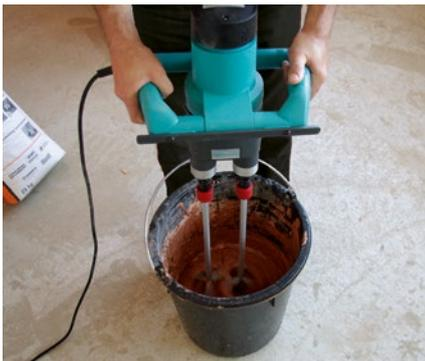
In einem sauberen 30 Liter-Eimer wird der mitgelieferte Dünnbettmörtel klumpenfrei angerührt. Mischzeit ca. 3 Minuten. Mörtel reifen lassen und nochmals durchrühren.
