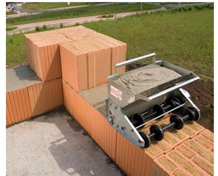
Mörtelwalze fortlaufend in eine Richtung ziehen (siehe Beschriftung am Gerät), dabei die Laufrollen auf die untere Ziegellage drücken.
