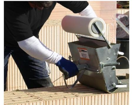
Öffnungsgriff betätigen und starten. Die V.Plus-Walze wird in Schrittgeschwindigkeit über die untere Ziegellage gezogen (den Behälter während der Verarbeitung nie völlig entleeren).
