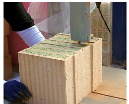
Restmaße werden mit gesägten Ziegeln geschlossen. Gesägte Flächen dabei immer nach innen richten und Stoßfugen mit LM 21 oder Kimm-schichtmörtel ausfüllen.
