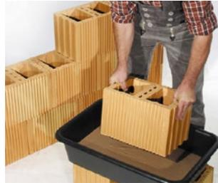
Der im Eimer angerührte Dünnbettmörtel wird in die Mörtelwanne gefüllt. Hier wird Ziegel für Ziegel kurz eingetaucht, der Mörtel haftet sofort fest an der Ziegelunterseite.
