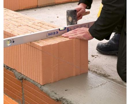
Die erste Ziegellage wird auf das exakt abgezogene Mörtelband gesetzt und mit Wasserwaage und Gummihammer feinjustiert.
