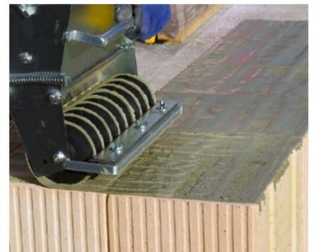
In Ecken wird die V.Plus-Walze nur bis zur Innenecke gefahren. Eine Wanddicke vor der Außenecke wird das benetzte Vlies mit dem Teppichmesser durchtrennt. Die Walze wird umgesetzt und an der rechtwinklig verlaufenden Außenecke neu gestartet.
