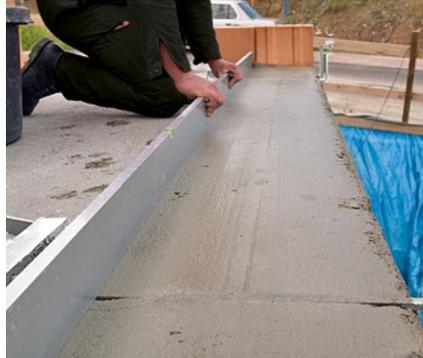
Um Unebenheiten der Bodenplatte auszugleichen wird die Mörtelausgleichsschicht aus Kimm-schichtmörtel (siehe Seite 25) mit Anlegefix und Alulatte maßgenau angelegt und abgezogen.
