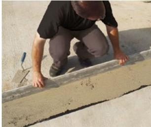
Wie beim normalen Planziegel-Mauern wird die erste Schicht maßgenau mit einem Mörtel der Qualität M10 (z.B. maxit therm 825) versetzt.
