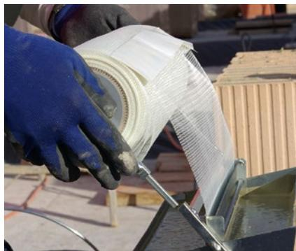
Ist die Lauflänge des Vlieses beinahe zu Ende, wird eine neue Rolle aufgesetzt und mit dem Rest der Vorgängerrolle verklebt (doppelseitiges Kleband ist nicht im Lieferumfang).
