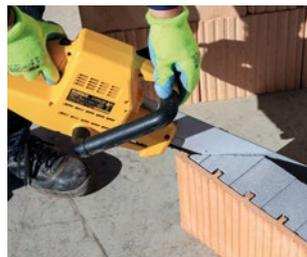
Mit der Steinsäge, einer Nass- oder Bandsäge können die Elemente an Ecken ganz einfach auf Gehrung geschnitten werden.
