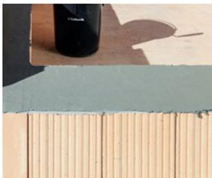
Mit der Mörtelwalze wird eine Schicht Dünnbettmörtel aufgetragen (alternativ kann auch die Verklebung mit dem als Zubehör angebotenen Planziegel-Kleber erfolgen).
