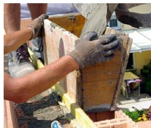
Die Befüllung des Planfüllziegels wird mit Beton C12/15 (Körnung 0-16, mit BV) durchgeführt. Danach kann die Decke betoniert werden.
