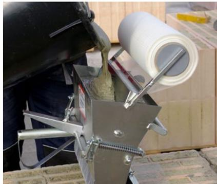
Vorratsbehälter beidseitig des Glasvlies-Führungskanals befüllen. Die Auslaufdicke mit der Verstellerschraube auf 2,0 mm einstellen.
