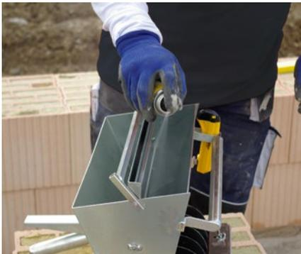
Erstes Anfahren: Gerät mit Trennmittel oder Schalöl einsprühen. Glasvliesrolle aufsetzen und Vlies mittig im Führungskanal des Vorratsbehälters einführen.
