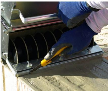
Das Glasvlies wird mit Hilfe der Abschnittsleiste und einem Teppichmesser an den jeweiligen Wand- oder Pfeilerenden abgetrennt, die Walze auf den nächsten Pfeiler in Warteposition gestellt.
