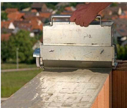
Die Mörtelwalze deckt in einem Arbeitsgang die Lagerfuge vollflächig mit Dünnbettmörtel.
