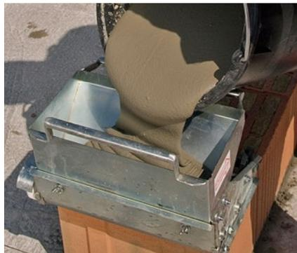
Der angerührte Dünnbettmörtel wird in die Mörtelrolle gefüllt. Damit wird der Mörtel rationell und einfach aufgetragen.
