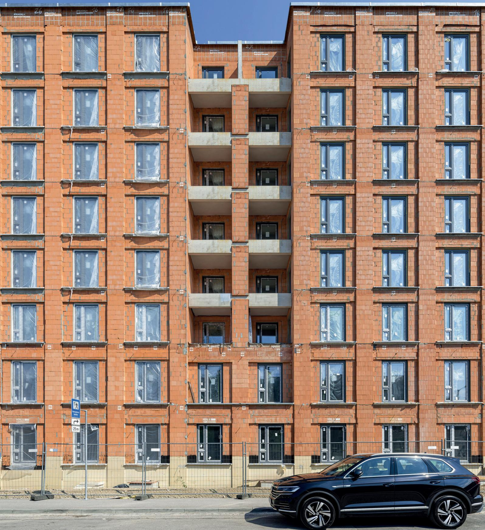
Baustoff für die Höhe: Der WS09 CORISO PLUS kann einer Belastung von bis zu 590 Tonnen auf einem Quadratmeter Wand standhalten. Durch die enorme Traglast ist es möglich, in monolithischer Ziegelbauweise noch weiter in die Höhe zu mauern.
