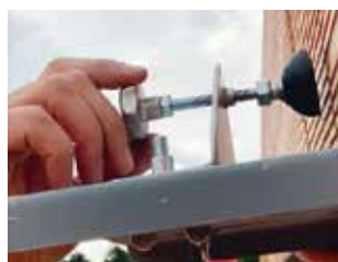
Fixierschraube an Innenwandung des Kastens anschrauben. Stütz-Fix ist jetzt fest mit dem Kasten verbunden.
