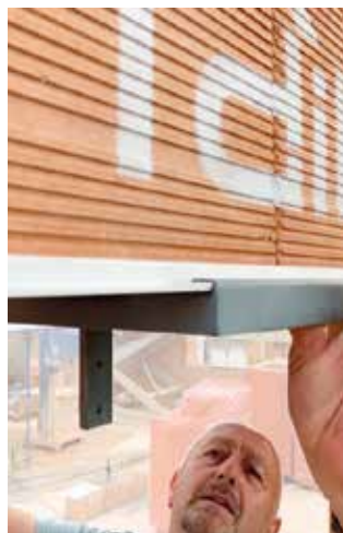
Einfahren des Aluminium-Abschlussprofils in der Umkantung des Stütz-Fix.
