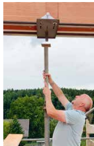
Arretierungszapfen an der Stahlstütze einstecken. Stütze ausrichten – FERTIG!
