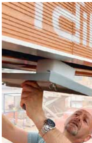
Platzieren des Distanzklotzes in der Revisionsöffnung des Kastens.
