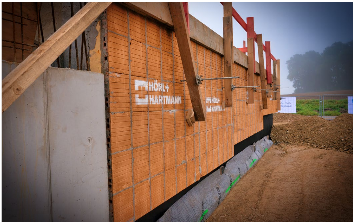
Jede Ziegelblende wird projektbezogen in individueller technischer Ausführung hergestellt. Eine zusätzliche Dämmung vor Ort ist nicht nötig.
