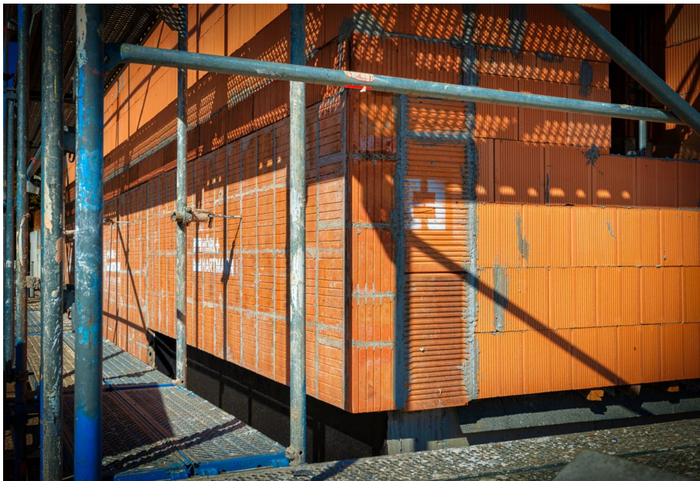
Perfekt als verlorene Schalung einsetzbar
