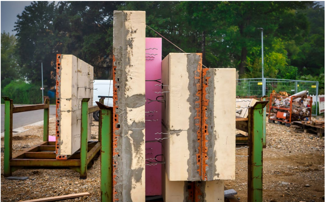
Jede Ziegelblende wird projektbezogen in individueller technischer Ausführung hergestellt. Eine zusätzliche Dämmung vor Ort ist nicht nötig.
