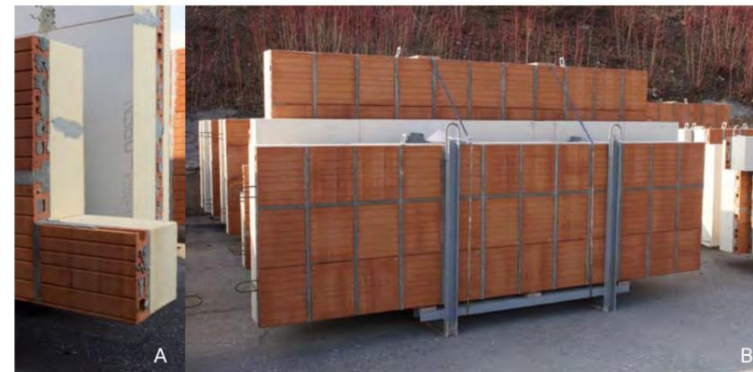
Abb. 18: Ziegelblenden mit Aussparungen (A) und zum Transport gesichert auf Spezialstahlpaletten (B).
