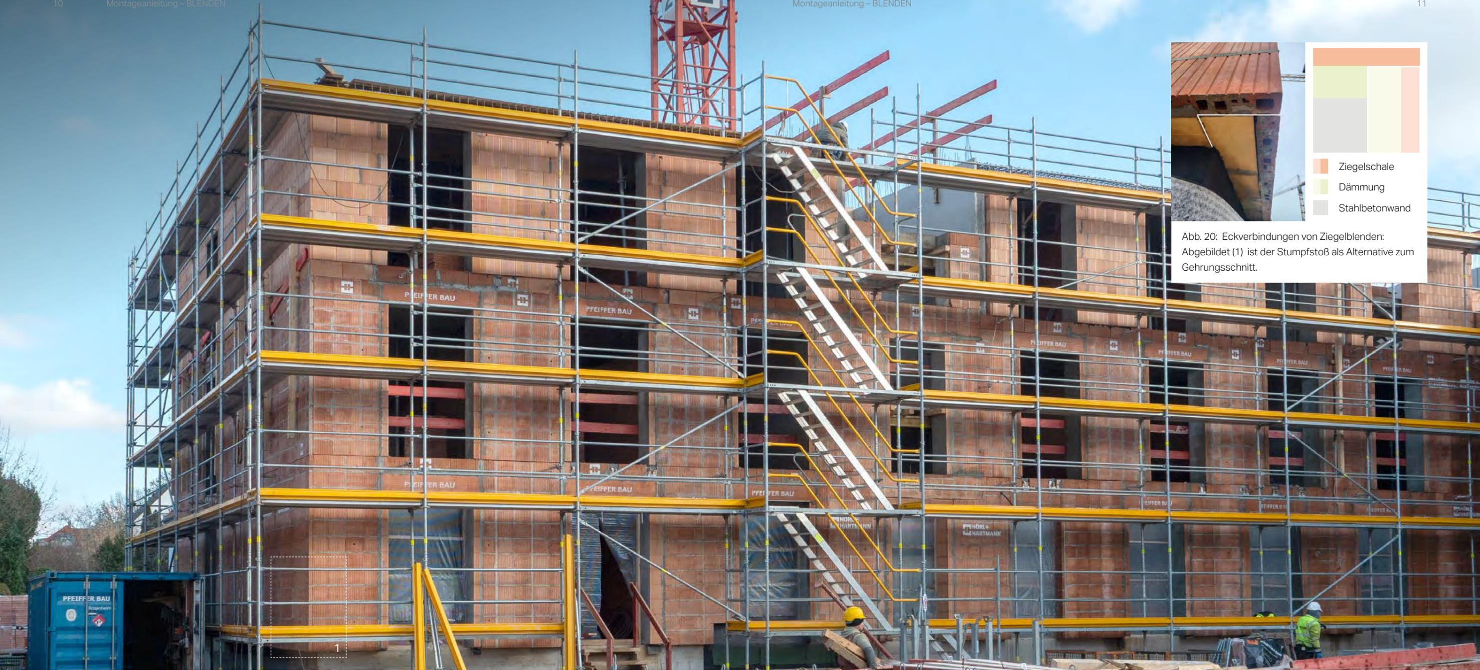
Abb. 15: Ziegelblenden im eingebauten Zustand während der Rohbauphase eines Mehrgeschossbaues.
