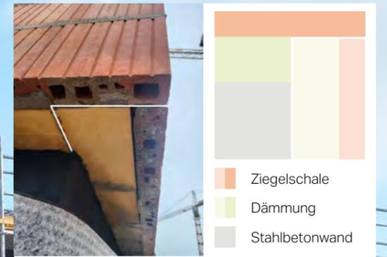
Abb. 20: Eckverbindungen von Ziegelblenden:
