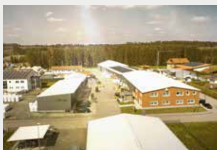
LEICHTBAUWERK WELDEN DIHA GmbH
