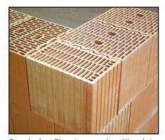
Durch den Einsatz von einseitig glatten Eck- und Anfängerziegeln wird das Überbindemaß sicher eingehalten
