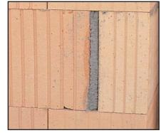
Fugenbreiten bis 5 mm sind bei verzahnten Stoßfugen zulässig. Darüber hinaus werden diese mit LM 21 ausgeworfen.
