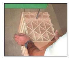
Ebenso werden Ziegel mit einer Nasssäge mit Diamant-Sägeblatt oder mit einer Bandsäge sauber und maßgenau zugeschnitten (bei der Ziegel-Bearbeitung ist das Beil fehl am Platz!).
