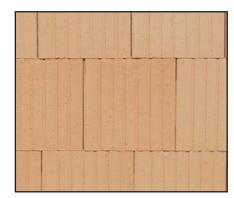
Mauerwerksverband nach DIN 1053-1 Abs. 9.3 = Überbindemaß > 0,4 x Steinhöhe. Bei Schichten von 25 cm ergibt sich ein Überbindemaß > 10 cm.
