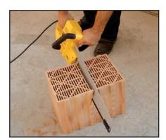
Maßgenaues Zuschneiden von Ziegeln mit Hilfe einer Ziegelsäge (z.B. DW 393 von DeWalt) ist durch das gegenläufige Sägeblattsystem rückschlagsicher und schnell möglich.
