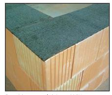
Das Mauerwerk ist vor Witterungseinflüssen (Regen, Schnee usw.) zu schützen, z.B. durch Abdecken mit Folien, Brettern oder Dachpappe.
