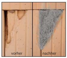
Fehlstellen im Mauerwerk werden mit Leichtmauermörtel LM 21 geschlossen.
