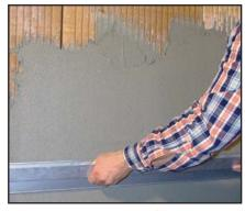
Ziegelmauerwerk ist aufgrund seiner Poren- und Kapillarstruktur ein besonders gut geeigneter Putzgrund.
