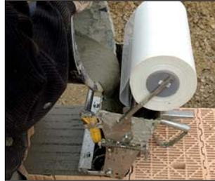
Vorratsbehälter beidseitig des Glasvlies-Führungskanals befüllen. Die Auslaufdicke mittels Verstellechraube auf 2,0 mm einstellen.
