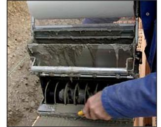
Das Glasvlies wird mit Hilfe der Abschnittleiste und einem Teppichmesser an den jeweiligen Wand- oder Pfeilerenden abgetrennt, die Walze auf den nächsten Pfeiler in Warteposition gestellt.
