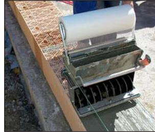
Öffnungsriff betätigen und starten. Die V.Plus®-Walze wird in Schrittgeschwindigkeit über die untere Ziegel-lage gezogen (den Behälter während der Verarbeitung nie völlig entleeren).
