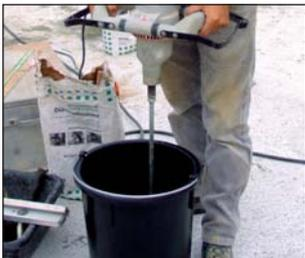
Mörtel in sauberem 30 Liter-Eimer mit Doppelrührquirl (z.B. Collomix DLX 152 HF) klumpenfrei anrühren. Mischzeit: 3 Minuten, Mörtel reifen lassen und nochmals durchrühren.
