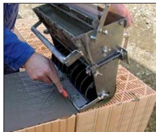
In Ecken wird die V.Plus-Walze nur bis zur Innenecke gefahren. Eine Wanddicke vor der Außenecke wird das beschichtete Vlies mit dem Teppichmesser durchtrennt. Die Walze wird umgesetzt und an der rechtwinklig verlaufenden Aussenecke wird neu gestartet.
