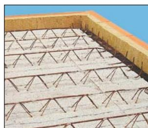
**Vorteile:** Vermeidung von Wärmebrücken, homogener Putzgrund, statisch belastbar, Verminderung der vertikalen Schall-Längsleitung, kein Kraftschluß zw. Beton und Abmauerung.
