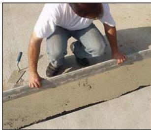
Wie beim normalen Planziegel-Mauern wird die erste Schicht maßgenau in herkömmlichen Mörtel versetzt.
