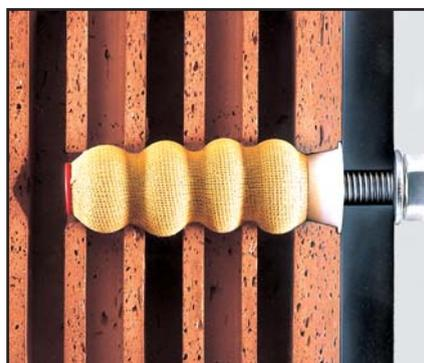
Für schwere Lasten gibt es z.B. Injektionsanker, die für sicheren Halt sorgen.
