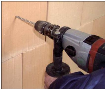
Bohrerdurchmesser ca. 1 mm kleiner als Dübeldurchmesser. **Schlagwerk ausschalten** - nur Drehbohren ist zulässig!
