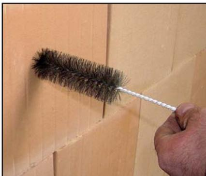
Bohrloch durch Ausblasen, Aussaugen oder mit Bürste reinigen (Bohrmehl beeinträchtigt die Haftung), erst dann Dübel setzen.
