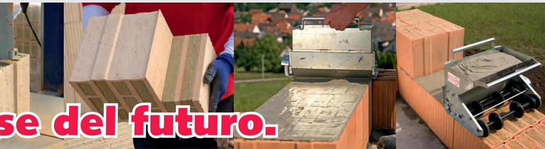
8. Kimmsteine sind Produkte, die bei nicht dämmendem Mauerwerk als erste Lage verwendet werden und deren  $\lambda$ -Wert kleiner 0,33 ist. Wärmedämmende Ziegel sind von Haus aus Kimmsteine.
