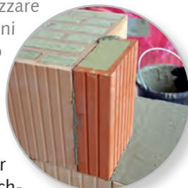
4. Bei unseren Planziegel-Verarbeitungssystemen wird die Fensterbrüstung ohne zusätzlichen Aufwand gegen eindringendes Wasser geschützt. Gleichzeitig werden beste Voraussetzungen für den nachfolgenden Fenstereinbau geschaffen! Für die Rahmenüberdämmung von Tür- und Fensteranschlüssen gibt es eine gedämmte Anschlagsschale.
