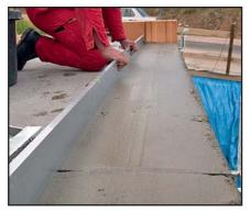
Successivamente viene predisposto a misura esatta con Anlegefix e stadia di alluminio l'attacco orizzontale e viene lisciato per eliminare le irregolarità del solaio.
