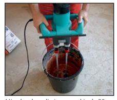
Miscelare la malta in un secchio da 30 litri pulito con un mescolatore senza che si formino grumi. Tempo di miscelazione: ca. 3 minuti, lasciare maturare la malta e miscelare ancorea una volta.
