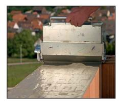
Il rullo ricopre con una sola passata l'intera superficie del giunto di collegamento orizzontale.
