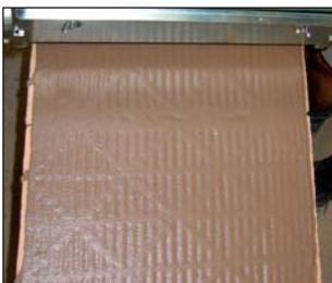
Il rullo per malta ricopre con una sola passata l'intera superficie del giunto di collegamento orizzontale.
