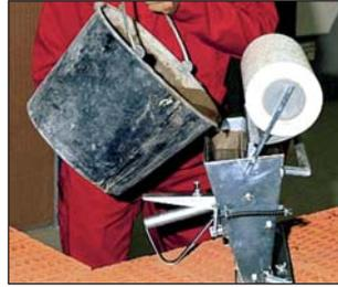
Riempire il serbatoio in modo che entrambe le parti del canale guida siano piene. Regolare su 2,0 mm, con l'apposita vite, lo spessore dello strato da stendere. Azionare la maniglia di apertura e cominciare la stesa.
