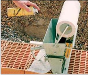
Prima operazione: Spruzzare il rullo con olio per casseforme o disarmante. Mettere in posizione il rotolo di rete in fibra di vetro ed introdurre la rete in maniera centrata nel canale di guida del serbatoio.
