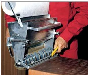
La rete di fibra di vetro si taglia al termine di ogni parete o di ogni pilastro con l'ausilio di un listello da taglio ed un coltello per moquette, il rullo viene messo in posizione di attesa sul pilastro successivo.
