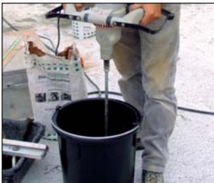
Miscelare la malta in un secchio da 30 litri pulito con un mescolatore (tipo Collomix DLX 150) senza che si formino grumi. Tempo di miscelazione: 3 minuti, Lasciar maturare la malta e miscelare ancora una volta.
