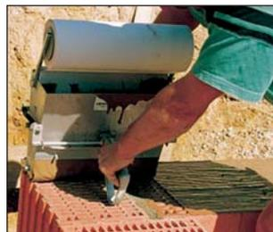
Negli angoli il rullo V.Plus viene fatto scorrere lungo una parete solo fino all'angolo interno delle murature. Si taglia la rete di fibra di vetro spalmata di malta con il coltello da moquette all'altezza dell'angolo interno delle due pareti e si riparte poi dall'angolo esterno delle pareti in direzione perpendicolare alla precedente.
