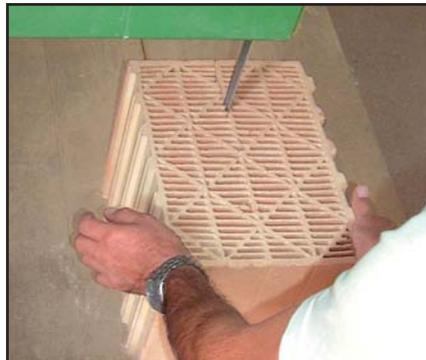
Allo stesso modo si tagliano i mattoni con una sega ad umido con lama diamantata o con una sega a nastro in maniera pulita e precisa ( per la lavorazione dei mattoni la scure non è al posto giusto!)
