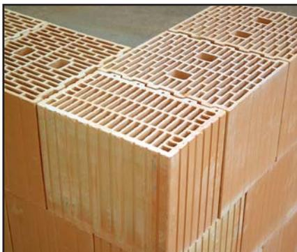
Con l'uso di mattoni per angoli e per inizio delle pareti senza immorsature su un lato si può rispettare sicuramente lo sfalsamento.
