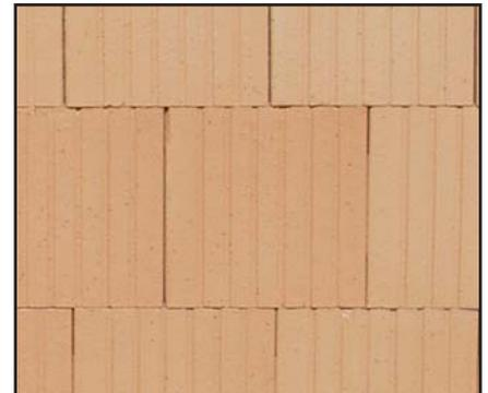
Legatura della muratura secondo le norme DIN 1053-1 art. 9.3 = sfalsamento  $> 0,4$  volte l'altezza dei blocchi. Per corsi da 25 cm si ricava uno sfalsamento  $> 10$  cm.
