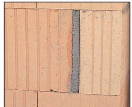
In caso di giunti verticali immorsati sono consentite larghezze dei giunti fino a 5 mm. Al di sopra di tale misura i giunti sono sigillati con malta LM21.
