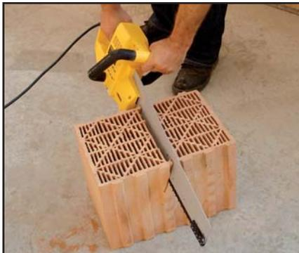
Grazie al sistema di marcia avanti ed indietro della lama della sega è possibile senza contraccolpi e velocemente tagliare con precisione i mattoni con l'impiego di una sega per mattoni (p.es. tipo DeWalt DW 393)
