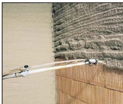
La muratura in laterizio per la sua struttura porosa e capillare è un buon sottofondo particolarmente adatto per l'intonaco.
