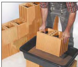
La malta speciale "Dünnbettmörtel" miscelata nel secchio viene versata nella bacinella da malta. Qui vengono immersi rapidamente i mattoni ad uno ad uno; la malta aderisce subito saldamente alla parte inferiore del mattone.
