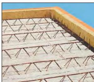
**Vantaggio:** evitare dei ponti termici, muratura omogeneo per il intonaco, staticamente portante, evitare la trasmissione dei rumori attraverso le strutture in direzione verticale.
