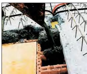
Il riempimento dei blocchi fonoisolanti PFZ viene eseguito con calcestruzzo C12/15 (granulometria 0-16, con plasticizzante). Dopo si può gettare il calcestruzzo per il solaio.
