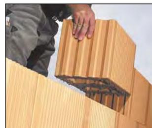
Dopo che il primo corso è stato posato sulla malta non viene ancora riempito di calcestruzzo, ma viene eretta la muratura per tutta la sua altezza con malta speciale "Dünnbettmörtel".
