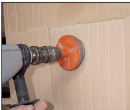
Tracciare le scatole elettriche e con un trapano normalmente in commercio ed una corona diamantata per fori circolari a secco eseguire un carotaggio.
