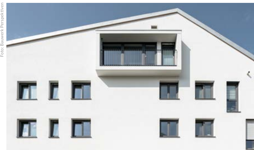
Wie ein Guckkasten ragt der Balkon des Dachgeschosses aus der Fassade. Die versetzte Anordnung der bodentiefen Fenster »stört« die Linienführung der Fenster.
