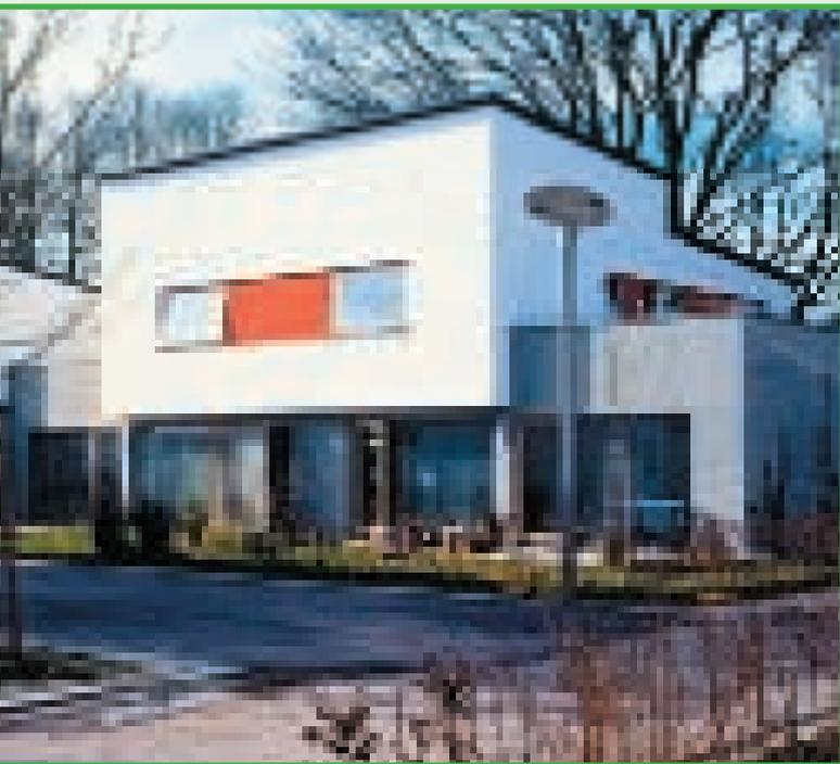
Auf dem Prinzip einer begrenzten Anzahl von Modulen entwickelte das Architekturbüro G.A.S.-Sahner, Stuttgart, im Auftrag der LBS kreative Systemhäuser. Aus mehreren Grundbausteinen entsteht ein individueller Gesamthauskörper. So gewährleistet das Konzept günstige Preise bei hoher Ausführungsqualität und die vom Auftraggeber gewünschte Vielzahl der Variationsmöglichkeiten.
