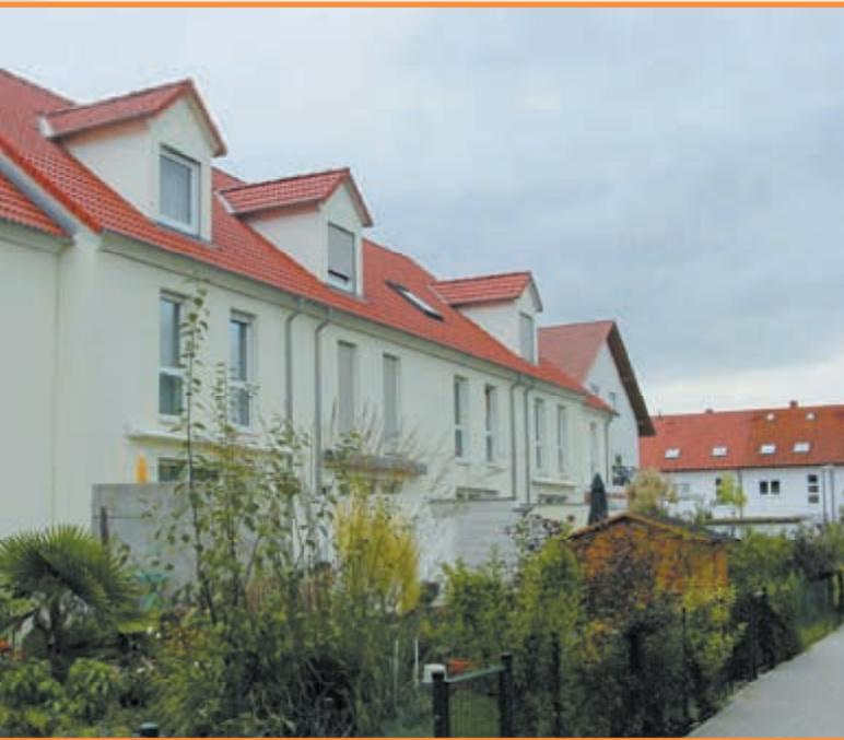
Die GAG Ludwigshafen plante 1995 ein ökologisches, „Norwegerdorf“ mit 19 Reihen- und Doppelhäusern in Holzbauweise. Um mit Holz bauen zu dürfen, wurden die Anforderung an die Trennwände zwischen den Häusern von F 90 A (nichtbrennbar) in F 90 B (brennbar) geändert.
